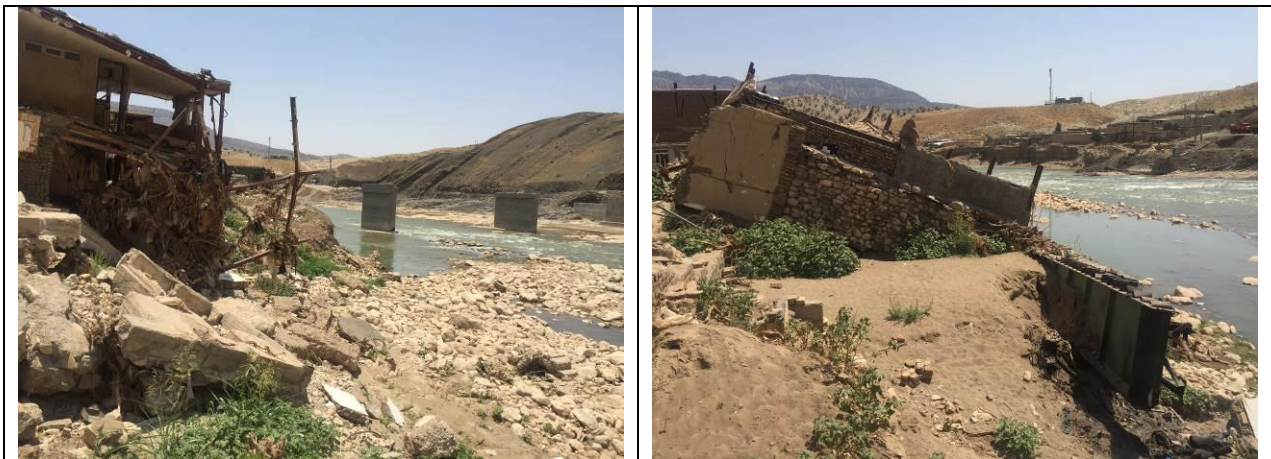
شکل ۴: بقایای پل در حال احداث عبوری از رودخانه کشکان
