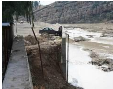
شکل ۴- عدم اتصال مناسب دیوار حفاظتی در ورودی شهر پلدختر در ساحل چپ رودخانه کشکان
